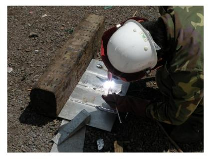
"细节决定成败",焊接环节尤其如此,加强过程控制,减少缺陷形成,能有效地提高一次焊接合格率,同时有利于返修合格。控制焊接质量,首先要充分了解和分析现场焊接缺陷产生的原因,然后结合现场实际采取有针对性的预防措施和控制对策,避免严重缺陷的产生,减少和消除焊接缺欠,切实解决焊接"气孔、夹渣、未融合、未焊透、烧穿、咬边、弧坑、裂纹、余高超标"等质量问题。现就常见的缺陷缺欠,以及冬季施工易出现的质量问题,进行成因分析及参考控制对策。
